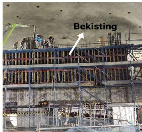
**Gambar 3.** Bekisting sarana pembantu struktur beton untuk pencetakan beton
