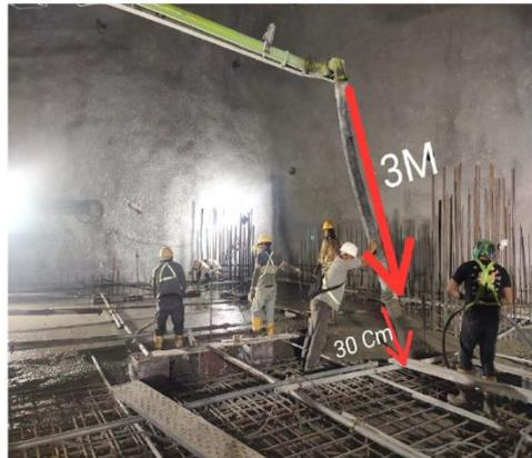
**Gambar 2.** Tinggi jatuh beton dari *truck concrete pump* di area (*control room*)
