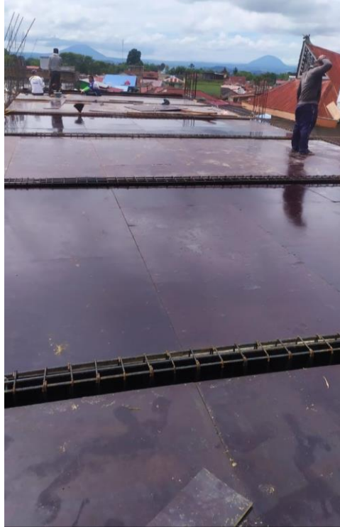
Gambar 5. Pemasangan bekisting dengan Garuda Foam (Sumber : PT. Archa Studio Arsitektur, 2023)
