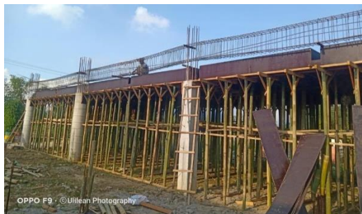
Gambar 3. Pemasangan perancah pelat lantai (Sumber : PT. Archa Studio Arsitektur, 2023)
