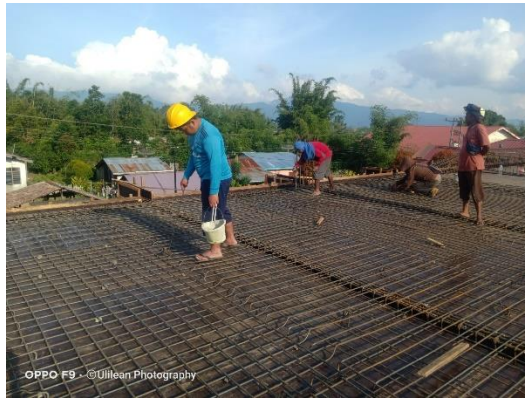
Gambar 10. Persiapan pengecoran (Sumber : PT. Archa Studio Arsitektur, 2023)
