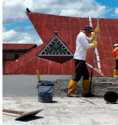
Gambar 12. Pemadatan beton cor (Sumber : PT. Archa Studio Arsitektur, 2023)
