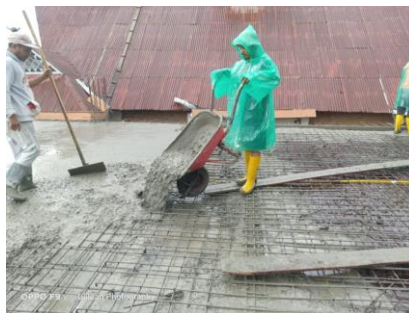
Gambar 11. Penuangan beton cor (Sumber : PT. Archa Studio Arsitektur, 2023)
