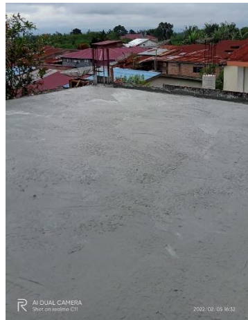
Gambar 13. Finishing pemadatan (Sumber : PT. Archa Studio Arsitektur, 2023)
