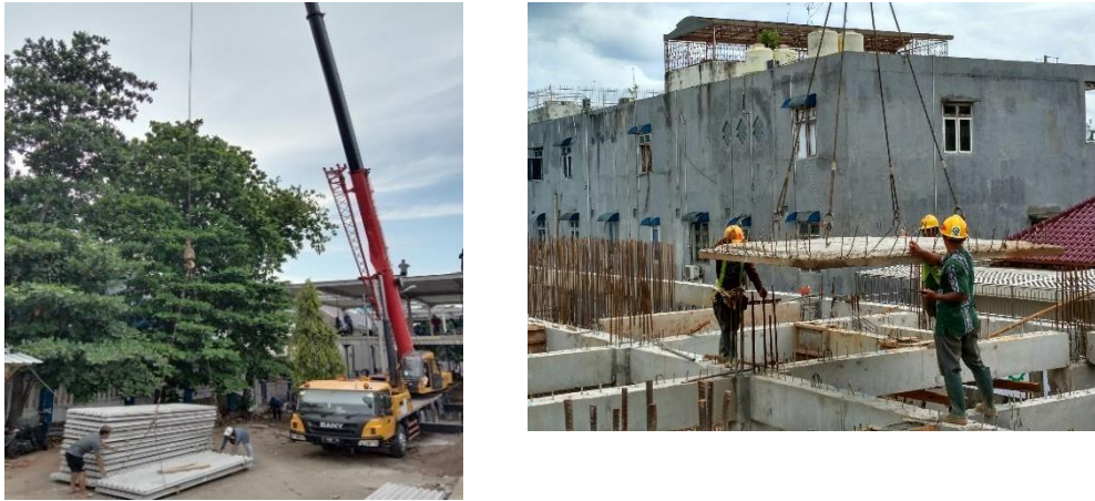
Gambar 14. Pemasangan precast (Sumber : PT. Archa Studio Arsitektur, 2023)
