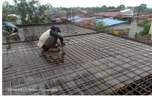
Gambar 6. Penulangan pelat lantai konvensional (Sumber : PT. Archa Studio Arsitektur, 2023)
