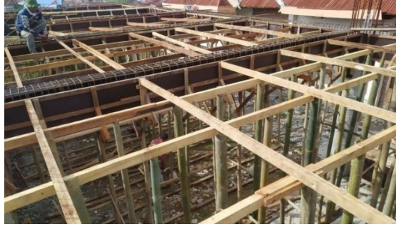
Gambar 4. Pemasangan mal pelat lantai (Sumber : PT. Archa Studio Arsitektur, 2023)
