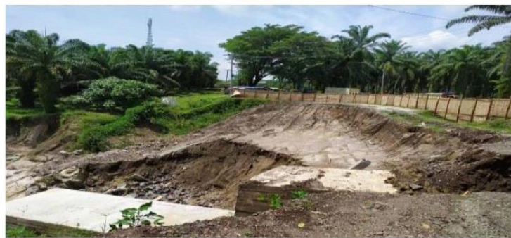
Gambar 6. Lokasi pembangunan turap, talud dan bronjong
