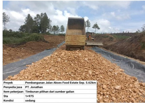
Gambar 4. Dropping material timbunan pilihan ke lapangan
