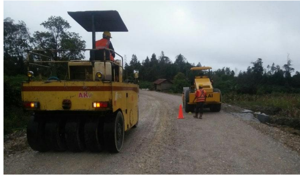
Gambar 9. Pemadatan timbunan pilihan menggunakan Spreading Vibratory Roller dan Pneumatic Roller
