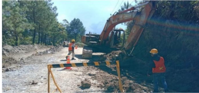
Gambar 2. Pembersihan lahan menggunakan excavator (sumber : dokumentasi lapangan, 2024)
