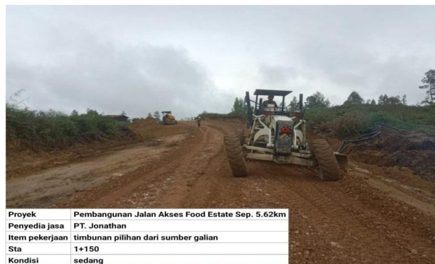
Gambar 3. Penghamparan material timbunan pilihan menggunakan Motor Grader (sumber : dokumentasi lapangan, 2024)
