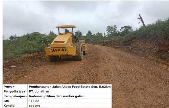
Gambar 5. Pemadatan timbunan pilihan menggunakan Vibro Roller
