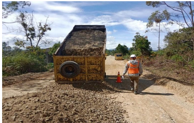
Gambar 8. Dropping material Base A ke lapangan (sumber : dokumentasi lapangan, 2024)
