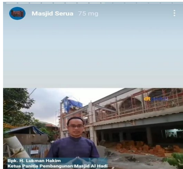
Gambar 5. Highlight Insragram Pembangunan Masjid
